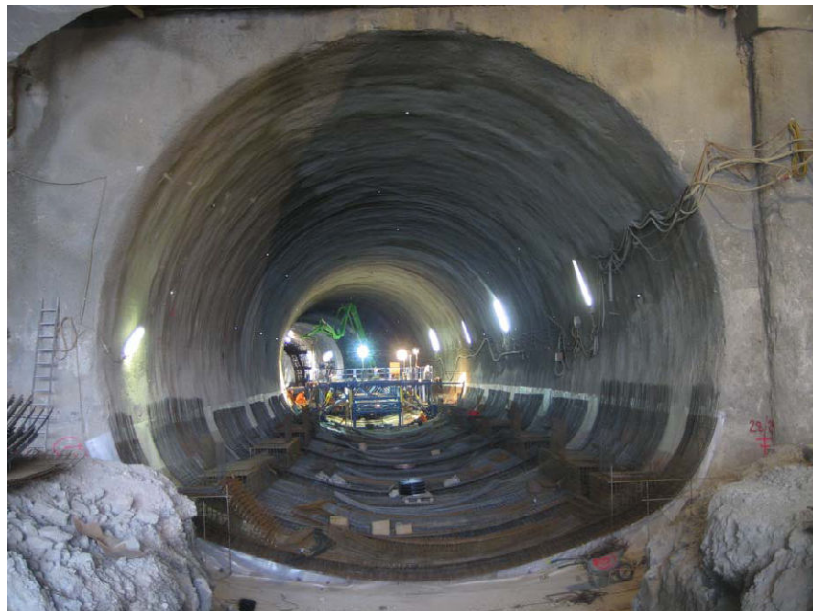
Figure 33, concrete lining (source Beton- und Monierbau)
