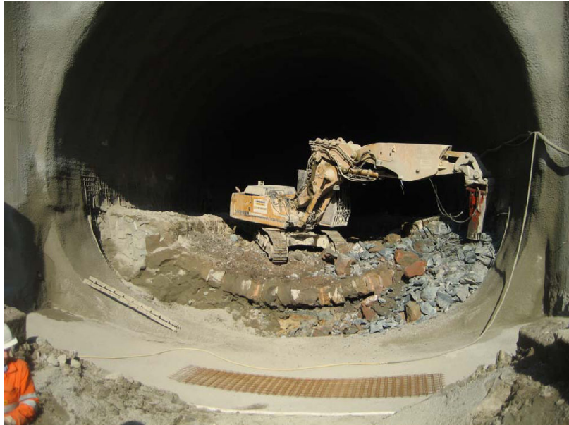
Figure 31, invert excavation (source Beton- und Monierbau)
