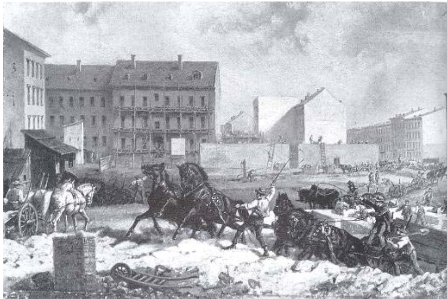
Abbildung 23: Bau von Mietskasernen in Berlin um 1875 [Quelle: Kaiser 1980]
